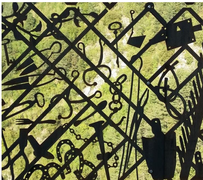
Ringhiera del Belvedere: particolare della decorazione a ritaglio su lastra in acciaio corten con oggetti della civiltà contadina.
